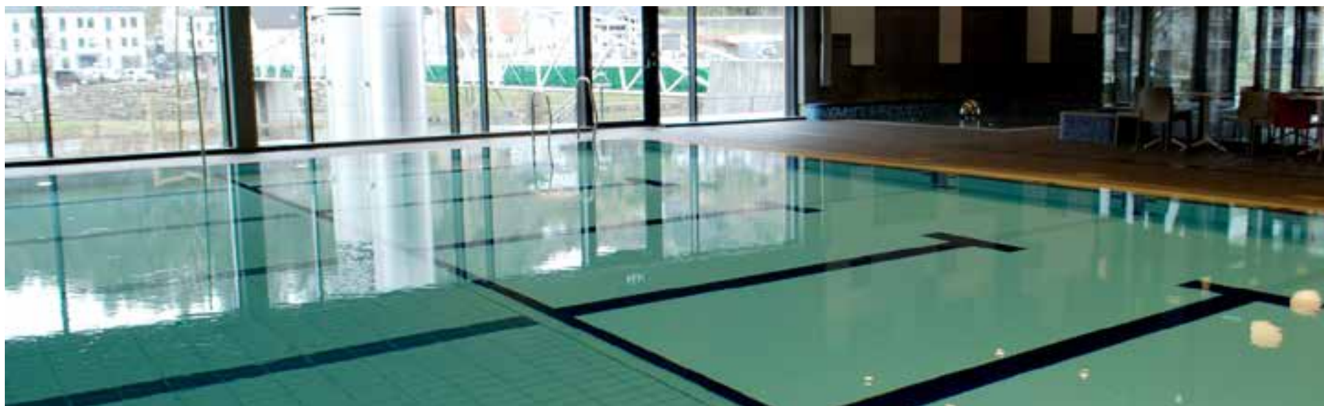
Her vises heve-/senkebunnen godt. Den egner seg veldig bra eksempelvis når det skal holdes svømmeundervisning for små barn. Når den heves, blir det ei god «grunne» å bevege seg på
