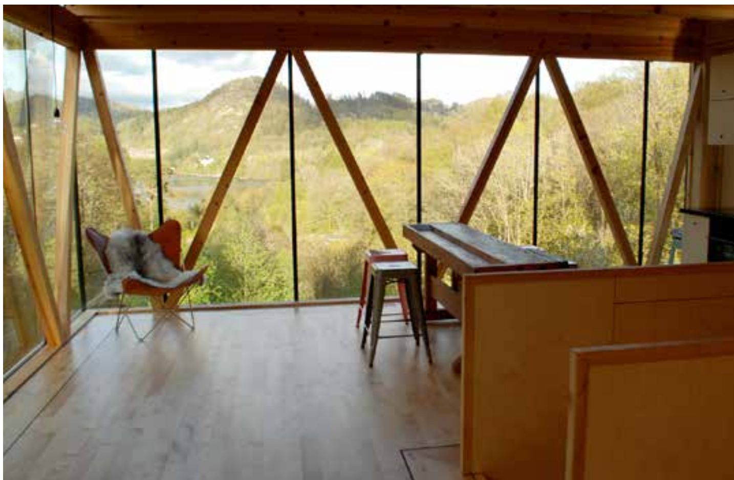
Denne typen bærebjelker kalles et fagverk, og danner en spennende brytning mot den praktfulle utsikten. Til høyre i front ser vi trappenedgangen som har vegger av doble sponplater
