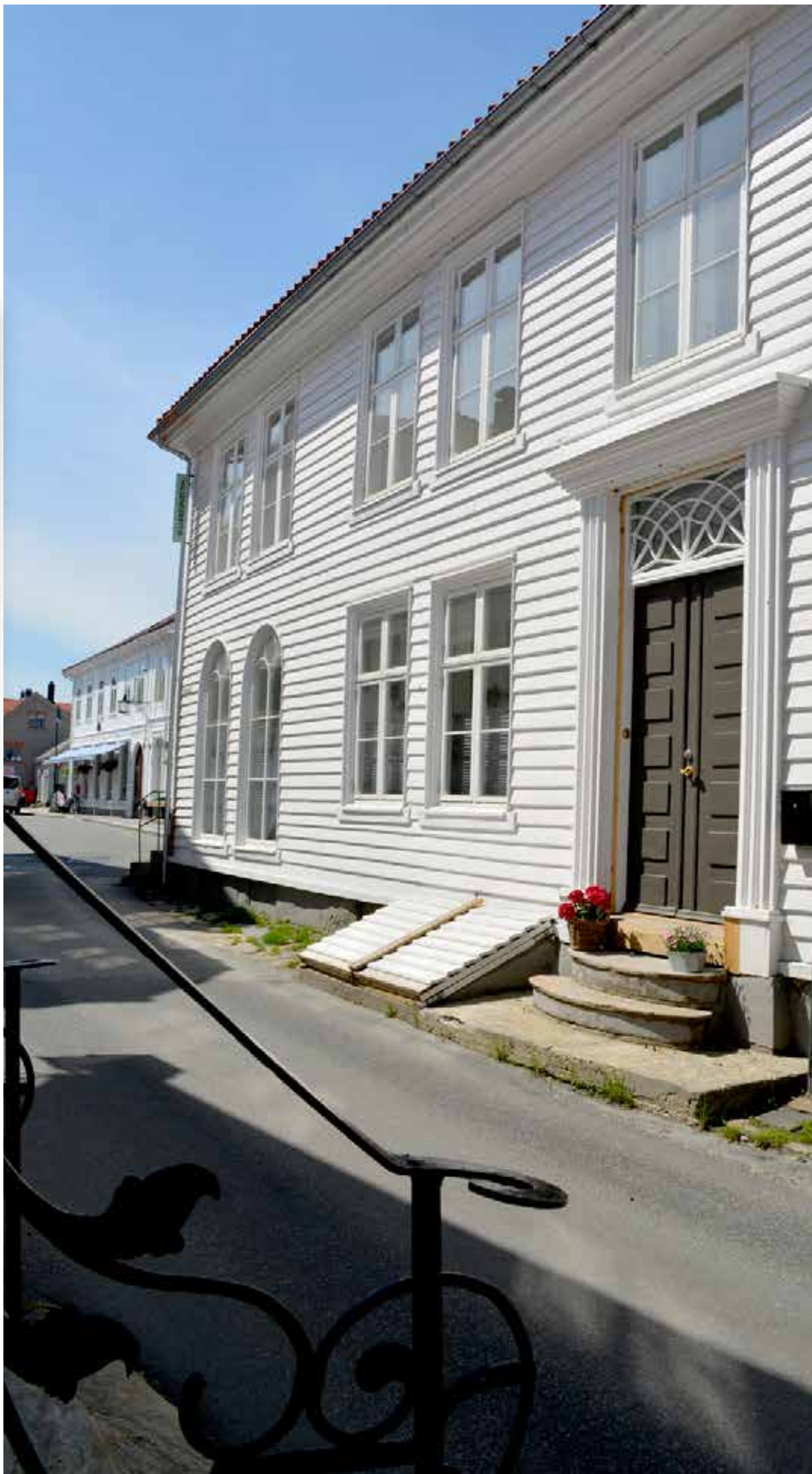
Fordums prakt. Kirkegaten 35 i Hollenderbyen i Flekkefjord har bevart fasaden, men inneholder fire topp moderne leiligheter.
