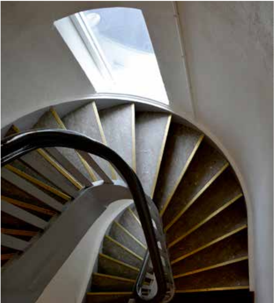
En vakker, gammel svingtrapp på baksiden av bygget fungerer som rømningsvei
