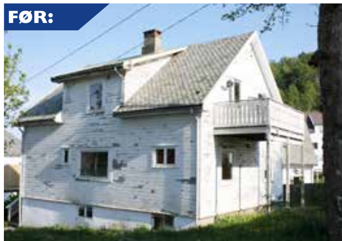
Dette var utgangspunktet før Hansen Bygg gikk i gang
