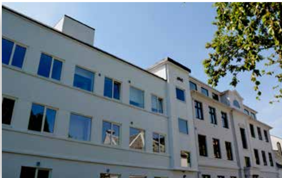
Selv om fasadene er de samme, har det foregått omfattende ombygging av Parkgaten 4 og 6.
