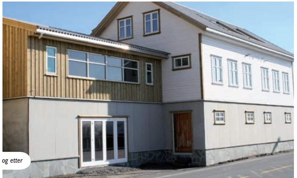
Oppussingsprosjekt på Borhaug: Før
